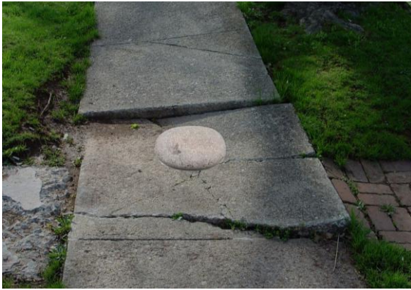
الشكل 17 عيوب في مواد الأسطح (تشققات، عدم الاستواء، برك المياه)
